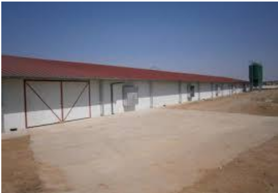
Figura 5 - Vista de um dos Pavilhões
